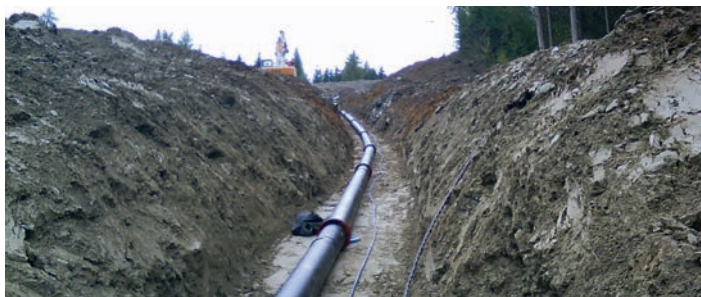
Úhlové odklonění do 5°, úspora času, tvarovek a finančních prostředků
