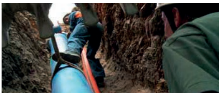
Pokládka na strmém svahu se sklonem až 85°
