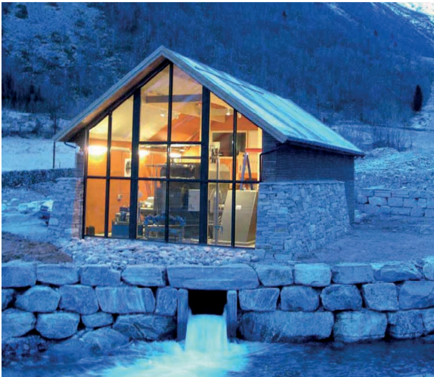
Turbínová vodní elektrárna Norwegen
