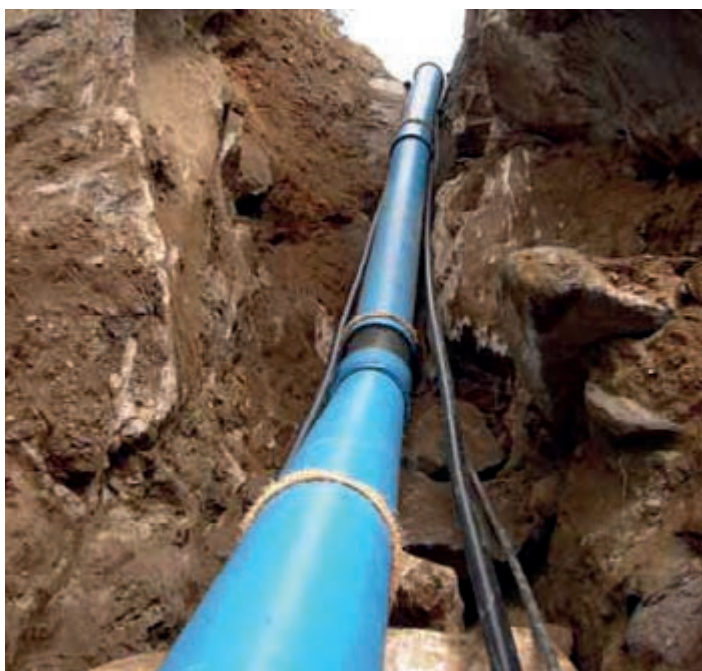
Pokládka trouby na skalnatém svahu
